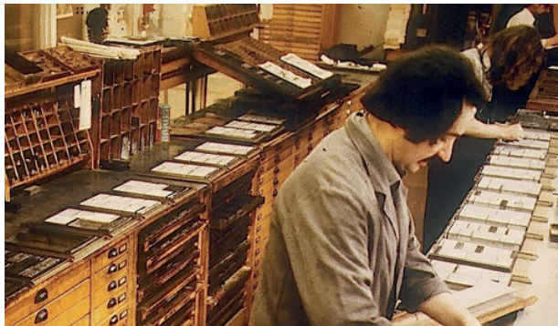
Håndsetting, fra et tysk trykkeri på 1970-tallet. Her ser det ut som om det legges siste hånd på verket - det ligger ferdige sider på benkene både foran og bak arbeiderne. Foto: Verlag und Druckerei Hintze GmbH - Wikipedia
